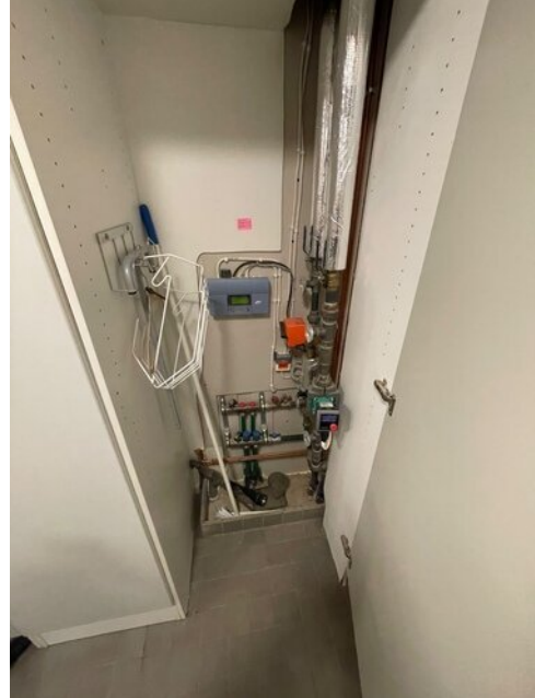
Lämmitysjärjestelmän jakotukki
